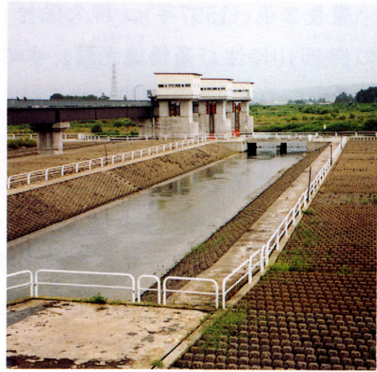
▲富川頭首工（北会津村真渡）
