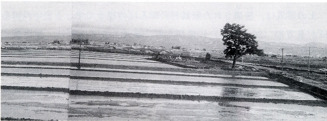
▲改良後（桧ノ目地区）
