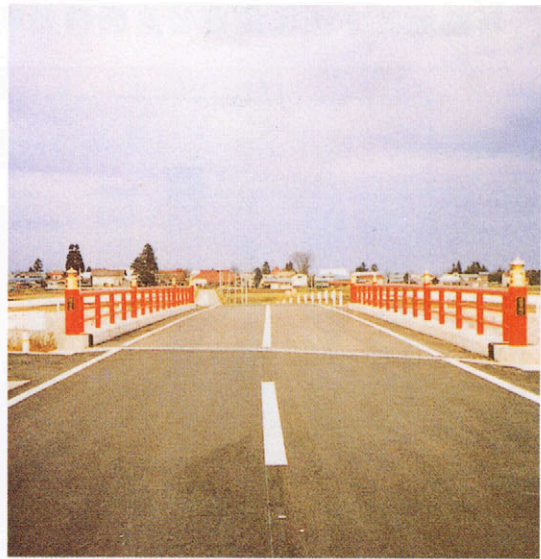
▲佐賀瀬川にかかる観音橋
