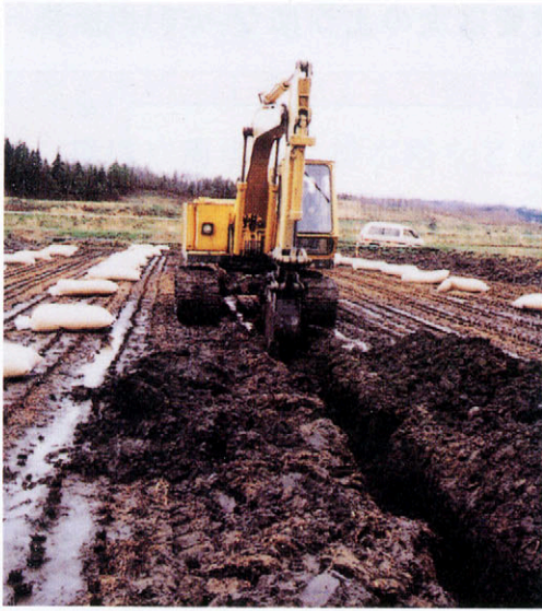
▲暗きょ排水工事
