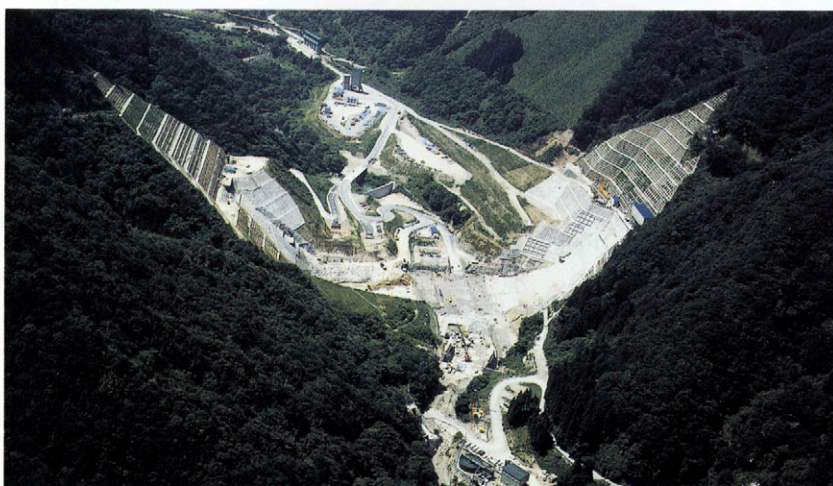
◀工事現況写真
