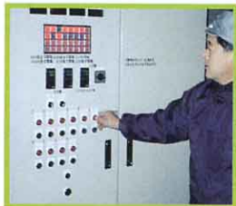
ごみ焼却場の機械を動かすそう置
