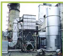
ガスれいきゃくとう（右）とマルチサイクロン（中央）とゆう引送風機とえんとつ（左）
