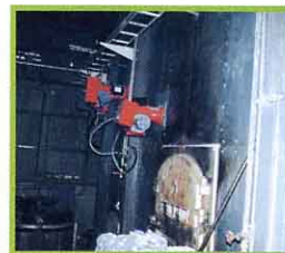
車ごとゴミの重さをはかる 燃しろう室へゴミを入れる 燃しろう室へ空気をおくる 助ねんバーナー（手前）と再ねんバーナー
