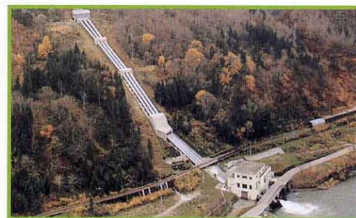
伊南川発電所
