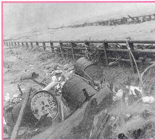
水害時の水沼橋
