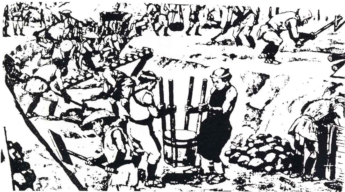
当時の工事の様子
