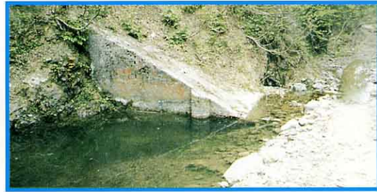
大塩堰の取入口（トンネル）
