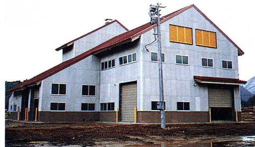
▲ ライスセンターの建物
