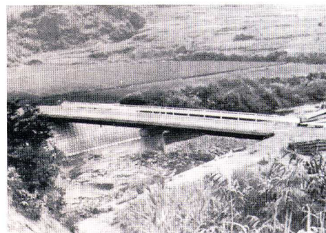
▲永久橋完成後の様子
