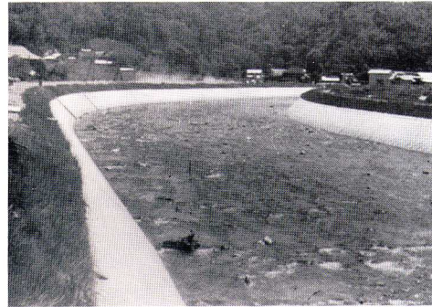
▲護岸工事完成後の様子
