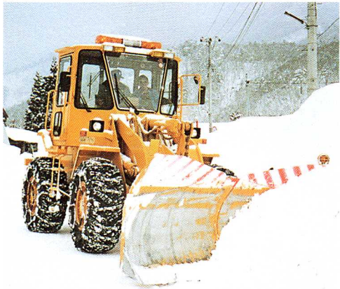
▲車輪式除雪車による除雪
