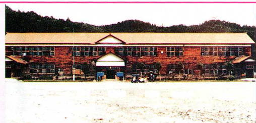
▲旧下中津川小学校
