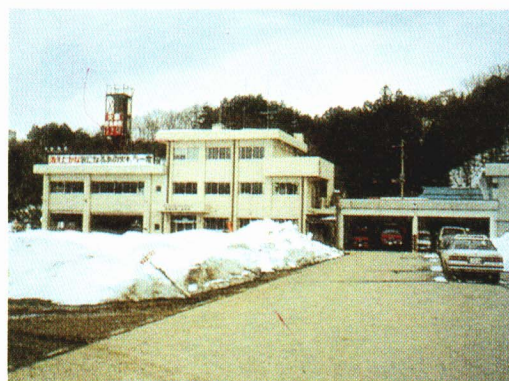
④南会津地方広域市町村圏組合 消防本部 (広域消防)
