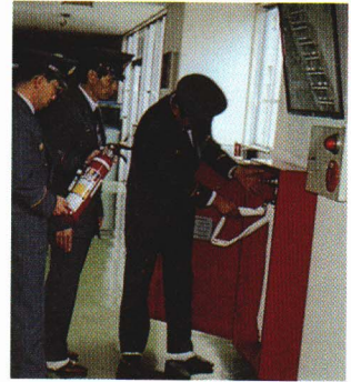
▲消火設備の点検
