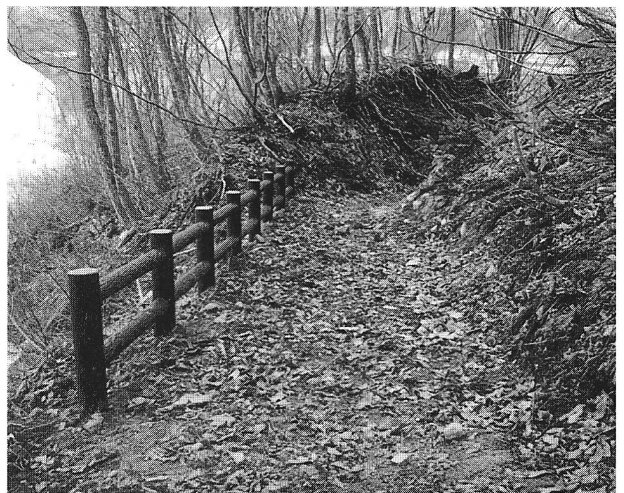
51 大内峠防護柵（施工後）図1
