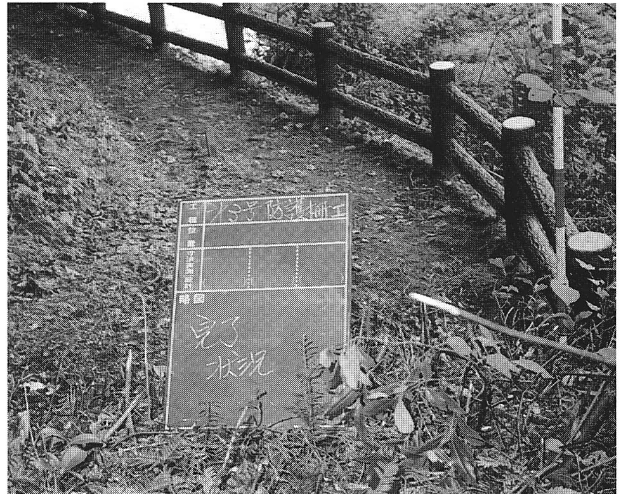
47 大内峠防護柵（施工後）図4
