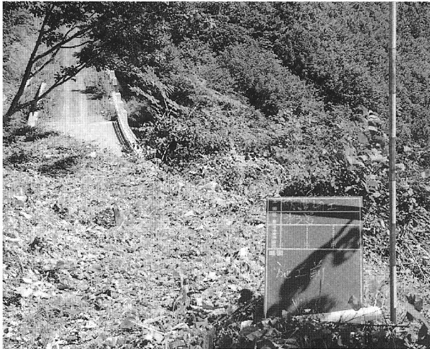
46 大内峠防護柵（施工前）図4
