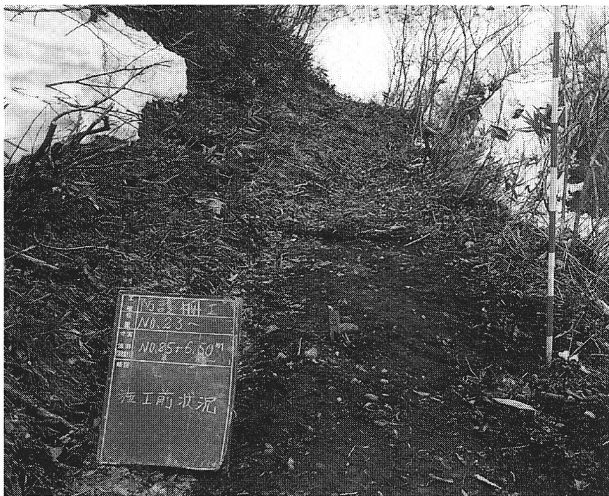
48 大内峠防護柵（施工前）図1
