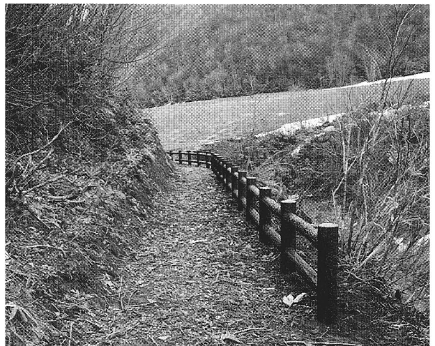
49 大内峠防護柵（施工後）図1
