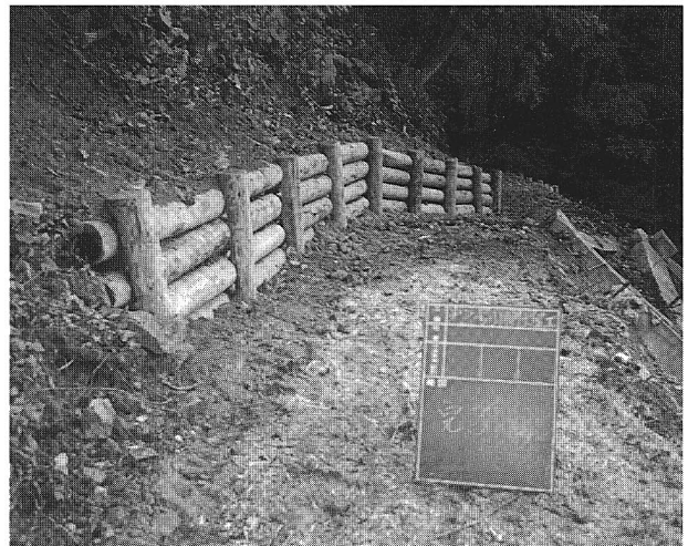
57 大内峠防護柵（施工後）図1
