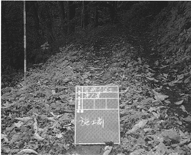
52 大内峠防護柵（施工前）図4
