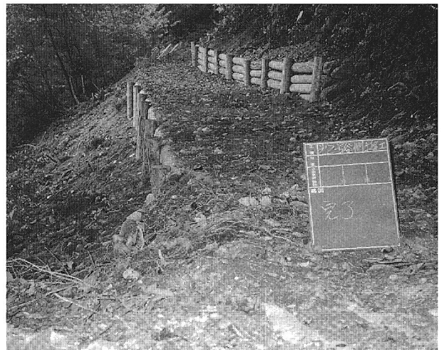
55 大内峠防護柵（施工後）図1
