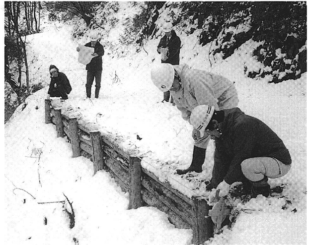
53 大内峠防護柵（施工後）図4
