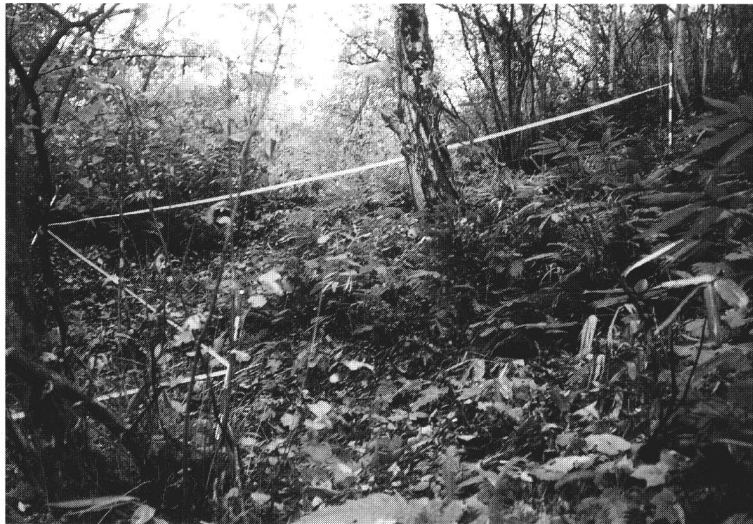
64 大内峠階段工 (施工状況)
