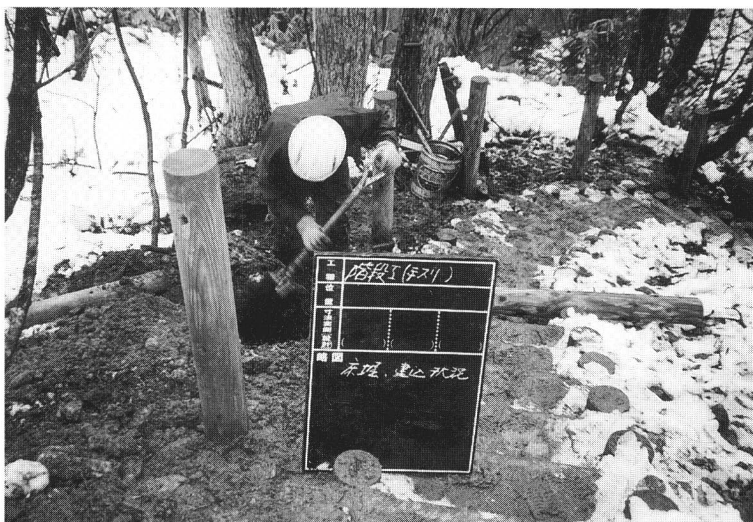
66 大内峠階段工 (施工状況)
