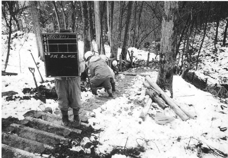
65 大内峠階段工 (施工状況)
