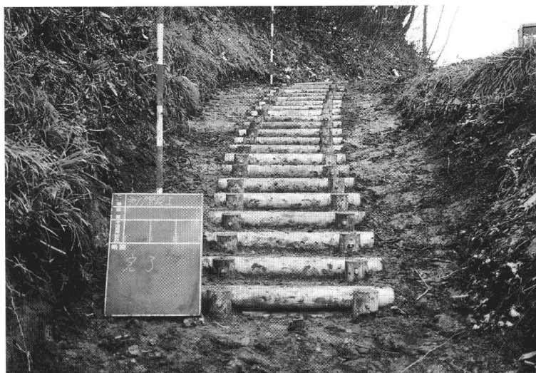
69 大内峠階段工 (施工後) 図2
