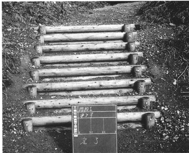
75 中山峠階段工（施工後）図34-19
