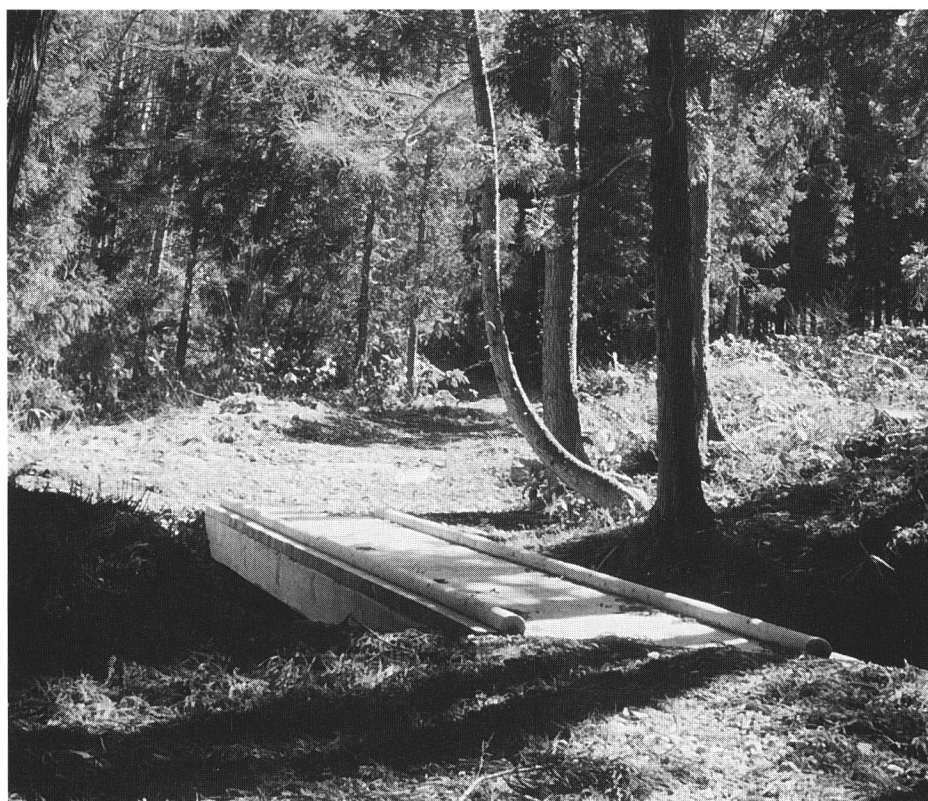
92 沼山峠木橋（施工後） 図34-7
