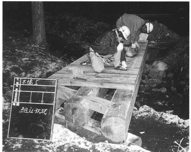
94 沼山峠木橋工（施工状況）図34-7
