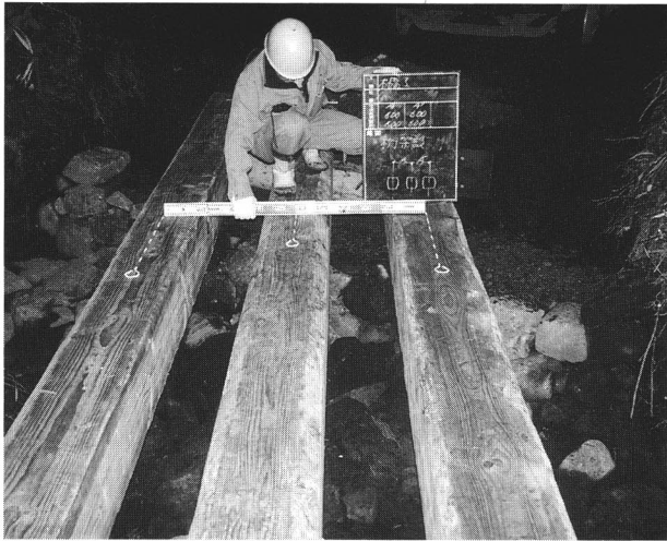
93 沼山峠木橋工（施工状況）図34-7
