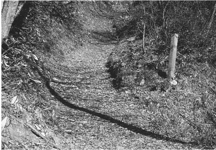
112 大内ダム入口 (施工前) 図1
