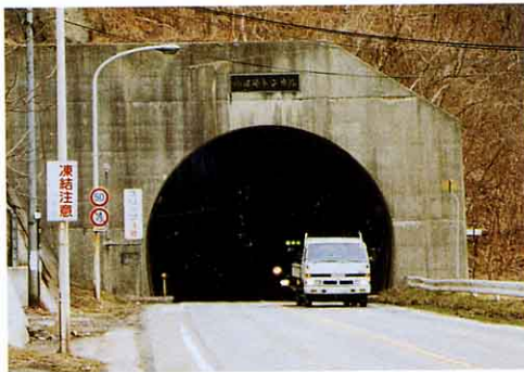
▲小沼崎トンネル (昭和50年)
