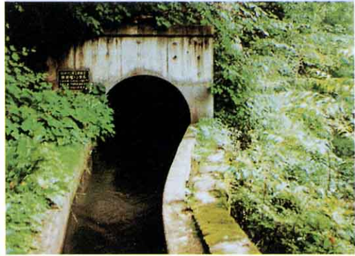
▲トンネルから流れ出る用水
