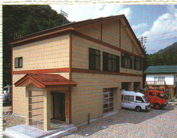
広域消防署 檜枝岐分遣所
