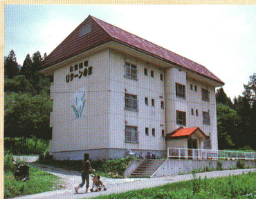
村営住宅「Uターンの家」
