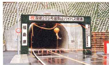
▲駒止トンネル開通(昭和57年11月12日)
