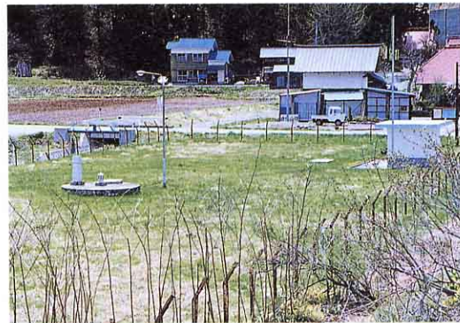
▲小野島浄水場
