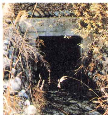
トンネルの出口
