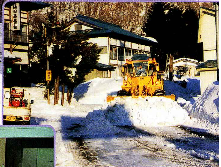
道路の除雪作業
