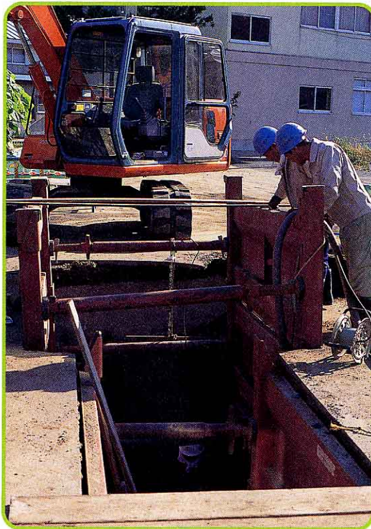
④ 下水道工事
