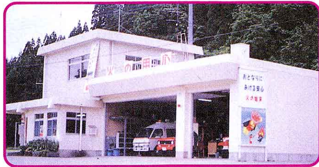
只見出張所にある消防の機械 (平成7年版 消防年報)
