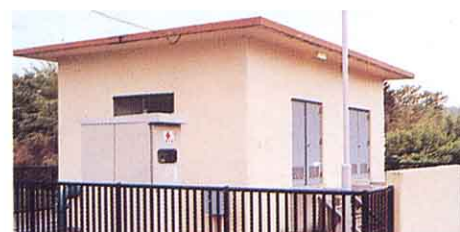
第5水源地 (山上字堀坂) やまかみあざほりさか
