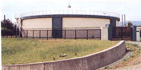
第2配水池 (粟津字芋堀) あわづあざいもほり
