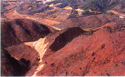
真野ダム工事着工前 (1980年)
