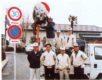
カーブミラー かーぶみらー の清掃
