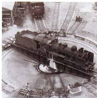
大正4年(1915)、原ノ町駅構内に転車台が設置された。転車台は機関車などの方向転換をするための回転台である。昭和42年(1967)に常磐線は全線電化され、昭和44年(1969)6月に転車台は使用中止となり、昭和55年12月撤去された。
