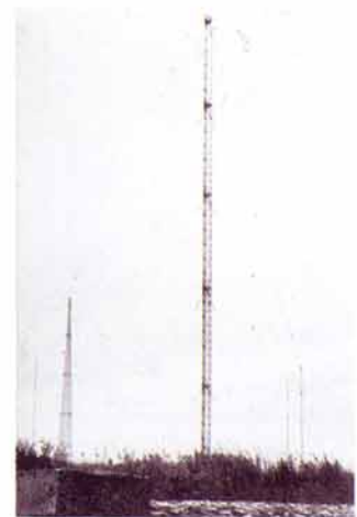
無線塔と副塔
