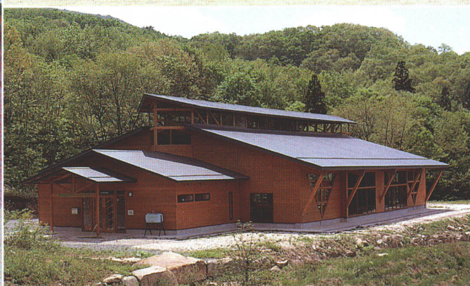
屋内ゲートボール場
