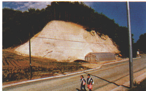
高尾中学校前のカコウ岩露頭 深部まで均一に風化している真砂。掘削は容易だが、ボロボロとくずれやすい。
