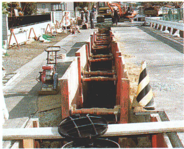
下水道の整備 Laying out a sewer system
