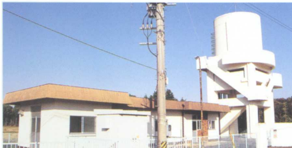
旭台増圧ポンプ施設
