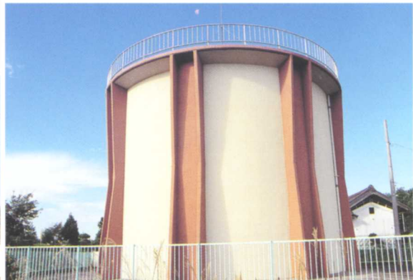
低地区配水池
