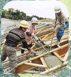
整備が進められている護岸
