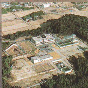
小山浄水場全景
