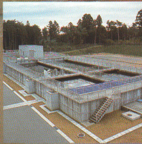
着水井・薬品沈澱池
