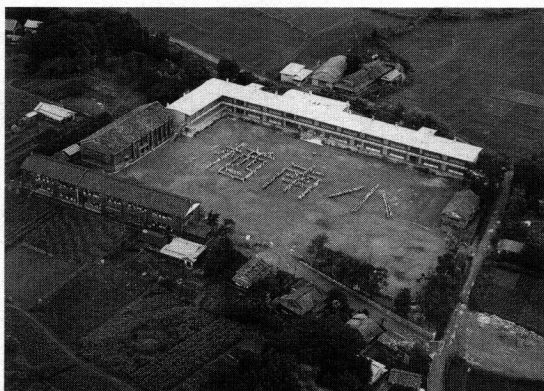
⑤ 南小学校校舎完成（昭和38年3月）
