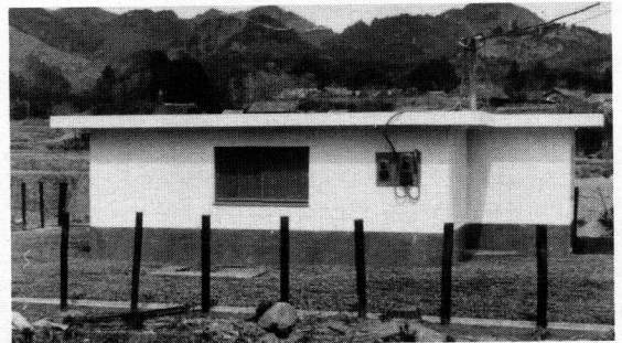
⑪ 広域簡易水道事業工事竣工（昭和48年3月）
