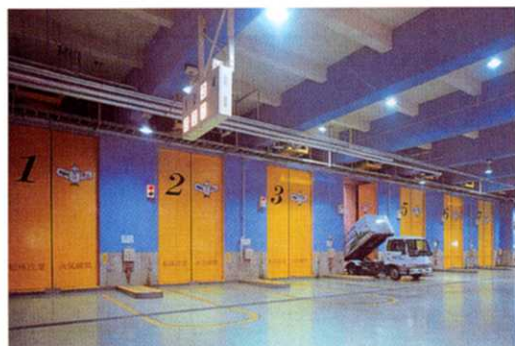
プラットフォーム ごみ収集車で集められたごみは、ここからごみピットに入れられます。
