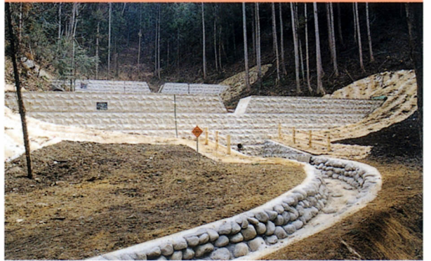
治山ダム(浅川町)
