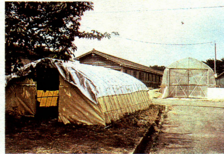
発酵・脱臭施設の全景
