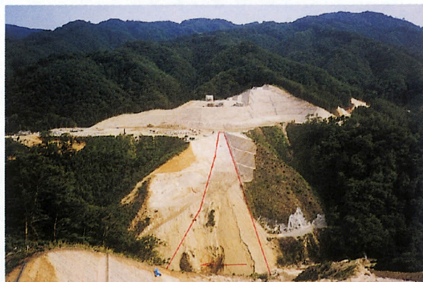
工事の進む木戸ダム(楮葉町)
